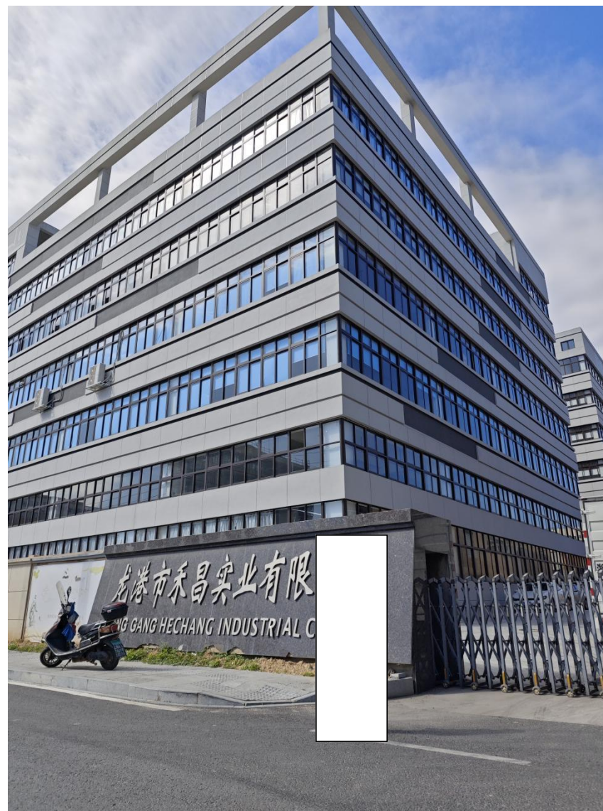
附图 1 编制主持人现场勘察照片
